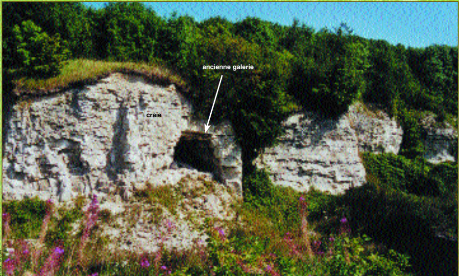
Les Anciennes Carrières de Cléty
